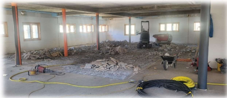
Abbruch Bodenplatten und Bodenheizung
